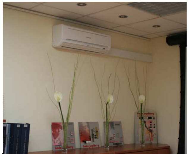
Innengerät (Wandgerät)
